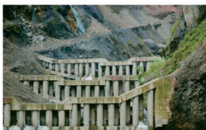
图1 北川县杨家沟桩林坝
